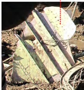
Odłamek lewej strony dźwigara nr 3 kesonu bakowego rozchodowego nr 1.
