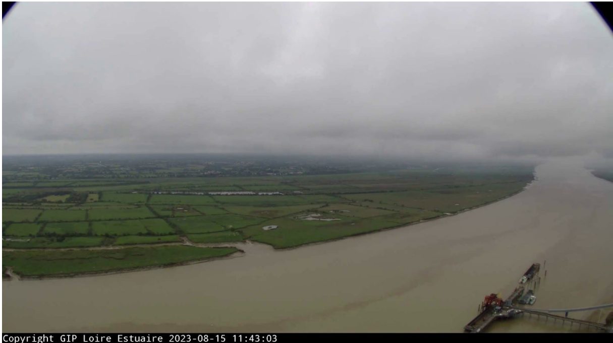
Figure 8 : vue de la caméra à 11 h 43 (Source : GIP Loire Estuaire)
